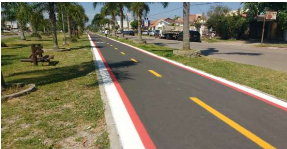
Figura 15- Exemplo de sinalização horizontal executada na ciclovias da Av. Rio Grande, em Rio Grande.
