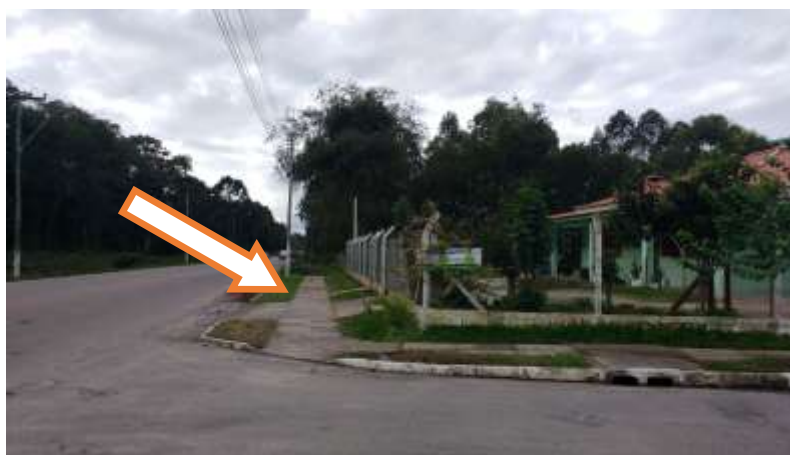
Figura 2 - Calçada a ser demolida, junto ao trecho 3
