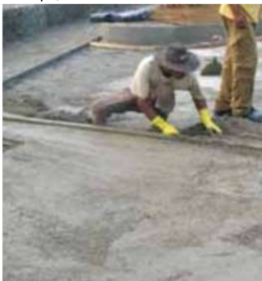
Figura 10 - Sarrafeamento do concreto
