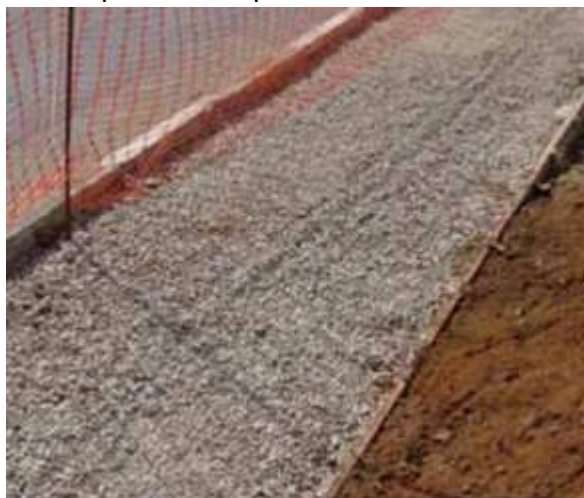
Figura 7 - Espalhamento da Camada de Brita
