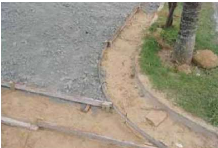
Figura 8 - Fixação das formas de madeiras
