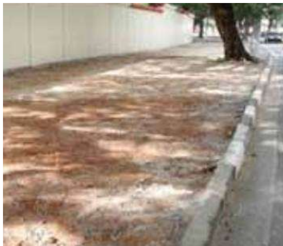
Figura 6 - Nivelamento e compactação do terreno
