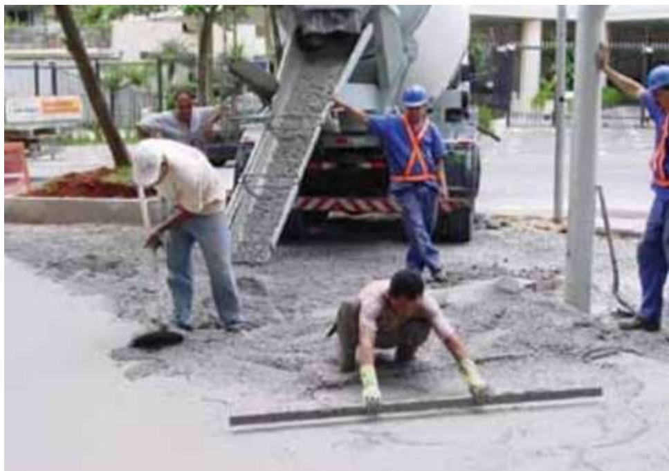
Figura 9 - Recebimento e espalhamento do concreto
